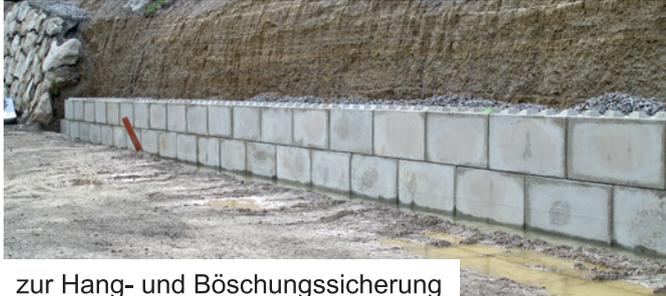
zur Hang- und Böschungssicherung
